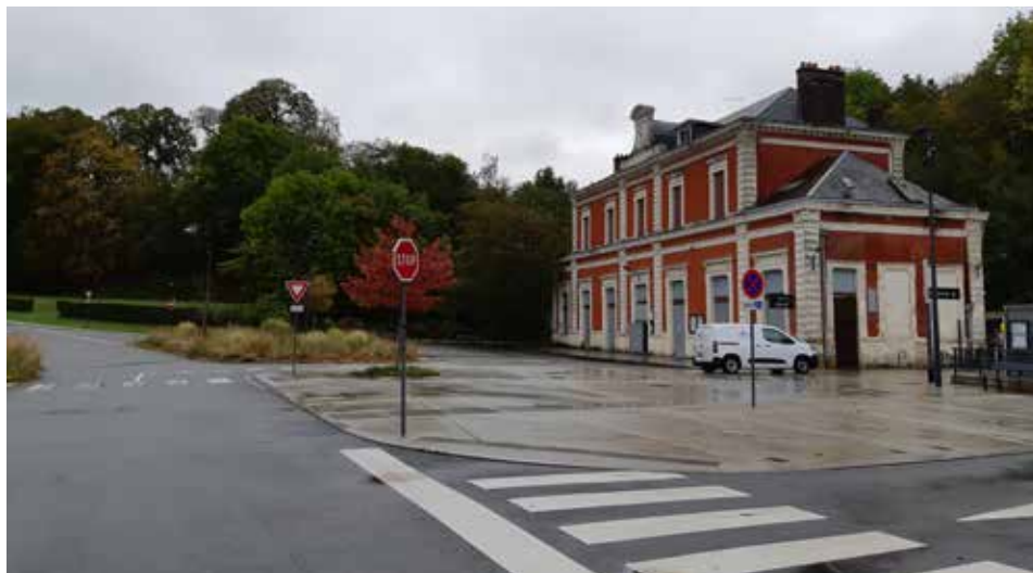
La gare de Conches-en-Ouche (27)
